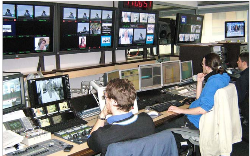
Die drei Kontrollräume für die englische, französische und arabische Sendeabwicklung sind nur durch eine dünne Wand voneinander getrennt.
