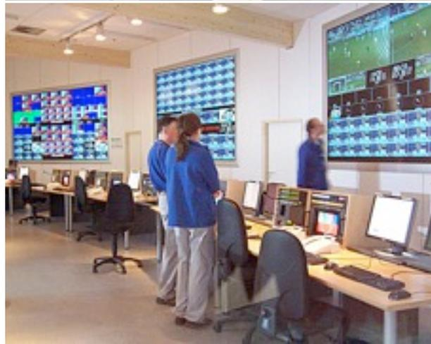
Durch mehrere große Fenster können Besucher und Mitarbeiter vom Hauptgang des IBC aus in den Monitoring-Bereich des Master Control Rooms schauen. Dort wird die Übertragung und Signalverteilung auf Multiviewer-Rückpro-Systemen überwacht.
