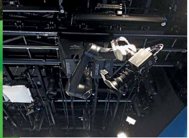
MRMC installierte eine spezielle Präzisionsschiene.
